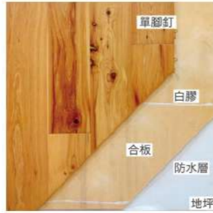
平鋪固定施工法
