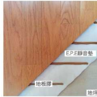
吸震固定施工法
